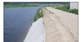
改修を終えた防災重点農業用ため池（大堤ため池）
