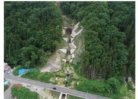
計画的な治山事業の整備 （溪間工・山腹工）
