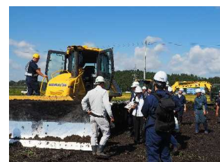
ICT活用に向けた現場見学会
