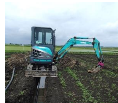
暗きょの補修作業
