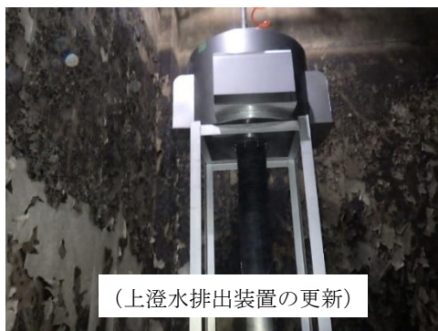
【集落排水処理施設の機器更新状況（おいらせ町、おいらせ町北部地区）】
