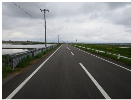
【農道整備（五所川原市 五所川原第二地区）】
