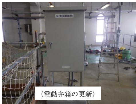
【集落排水処理施設の機器更新状況（おいらせ町、おいらせ町北部地区）】
