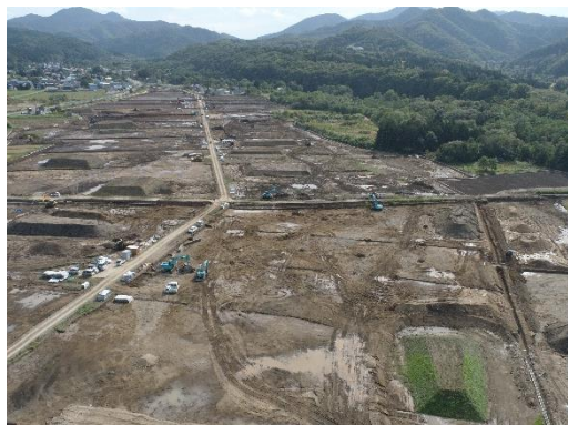
【区画整理工事の状況（青森市三本木・滝沢地区）】
