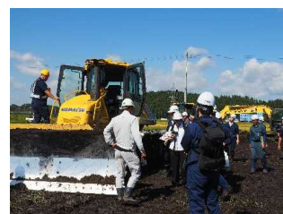
ICT活用に向けた現場見学会
