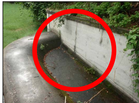
写真9：洪水吐流入部
