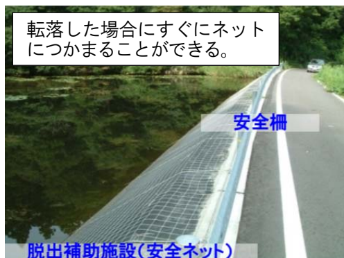
写真15：安全ネットの設置
