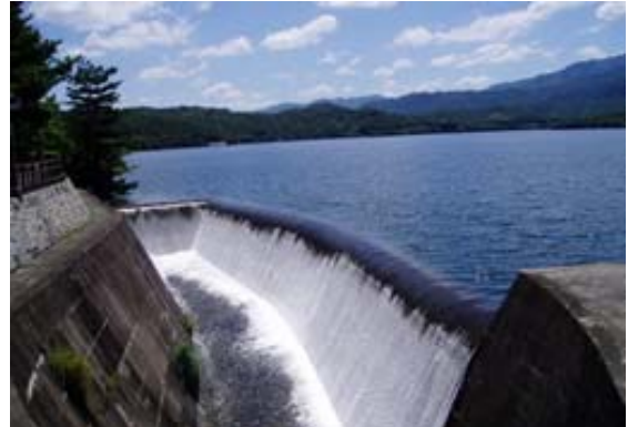
写真2：洪水吐 (香川県HPより)
