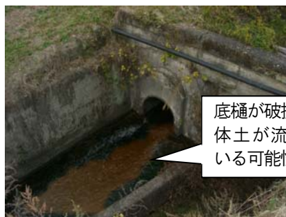
写真11：底樋出口（堤体下流）
