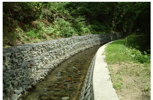
改修後の水路 (水路の底に石を配置)
