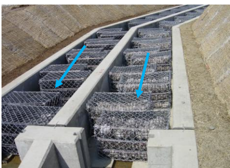
接触ろ材の設置
