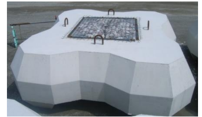
海底に設置しているコンクリートブロック（中央はホタテガイの貝殻）
