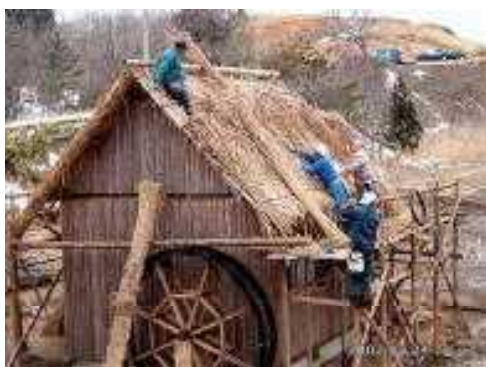
水車小屋の建設
