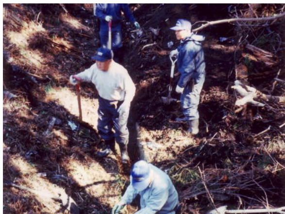
水路の補修・整備作業
