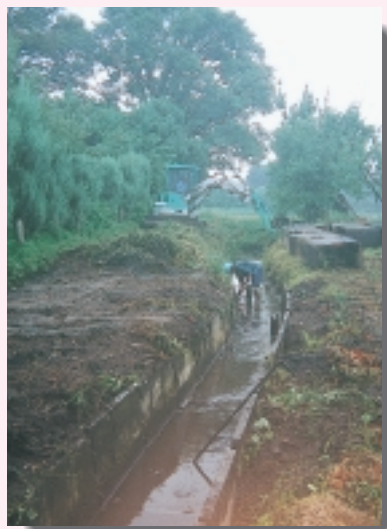
U字溝設置作業
