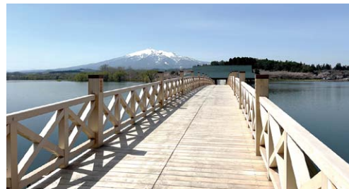
改修された「鶴の舞橋」
