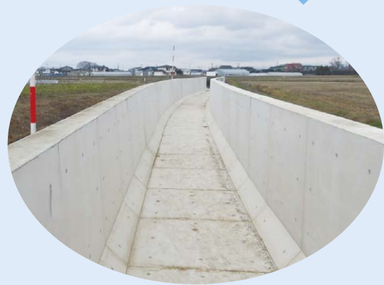
基幹水利施設ストックマネジメント事業 にしまた ごうかんせんようすいろ 西俣 1 号幹線用水路地区(つがる市)
