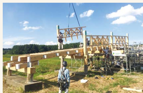
部材のユニット化
