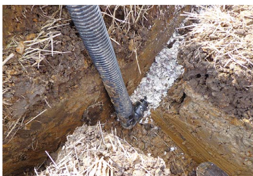
【暗渠排水の整備】
