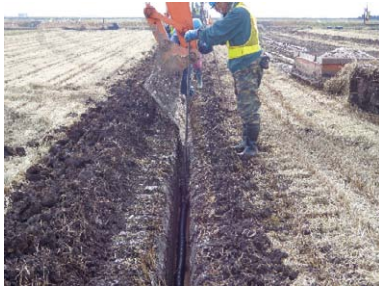
【暗渠排水の整備】
