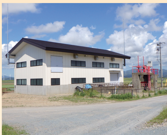
整備された排水機場 車力排水機場地区（つがる市）
