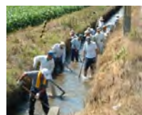
水路の泥上げ
