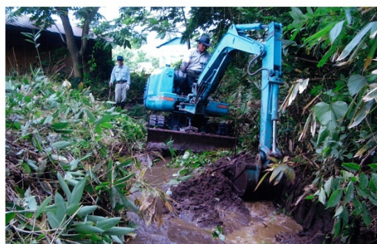
【共有機械による泥上げ作業】
