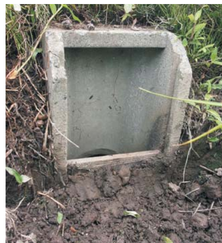
コンクリート製落水口
