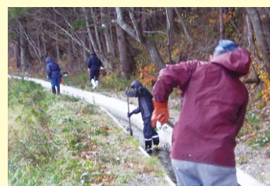
泥上げ作業の様子
