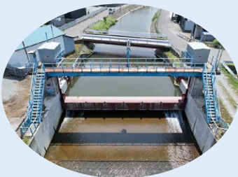
頭首工の 長寿命化
