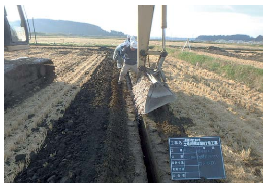
暗渠排水の整備（土場川地区）
