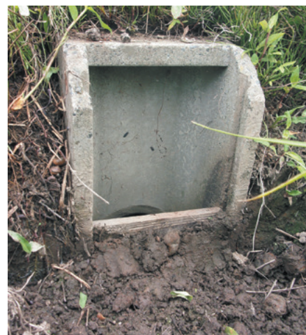
コンクリート製落水口
