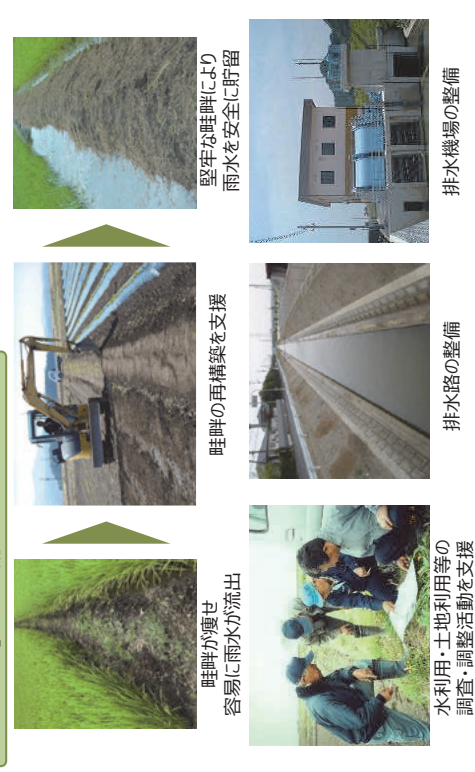
畦畔が壊れ、容易に雨水が流出
