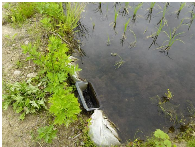
落水函（設置状況）
