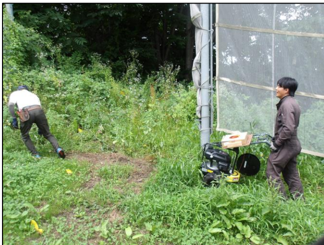
エリアケーブル埋設
