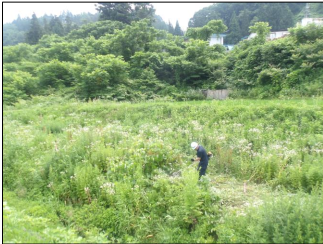
人力による草刈（法尻部）
