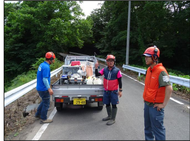
使用機械（ドローン）
