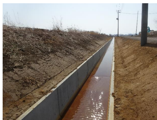
農業水路等長寿命化・防災減災事業 (水元排水路地区 つがる市 R3～R6)
