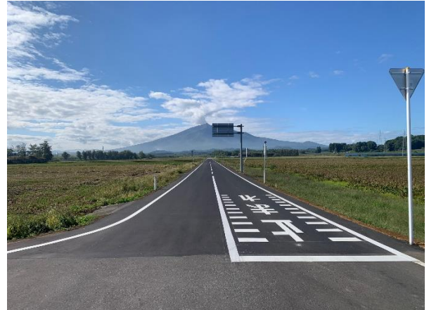
通作条件整備事業 舗装工
