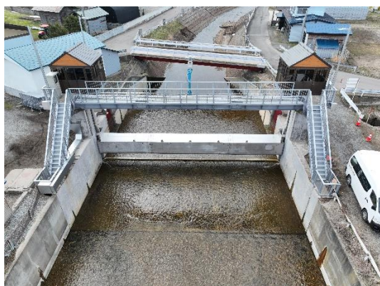
農業水利施設保全合理化事業 (小田川南部地区 五所川原市 H27～R8)
