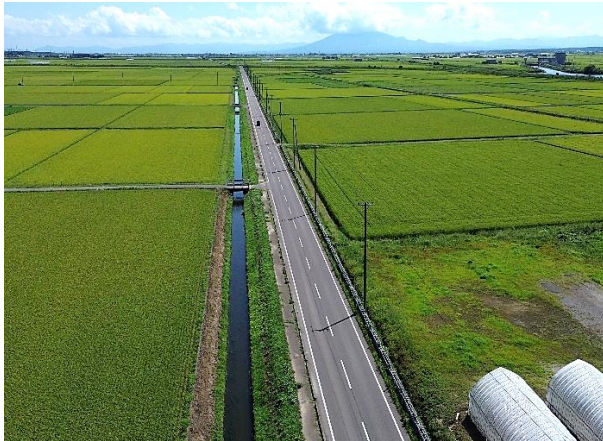
通作条件整備事業 舗装工
