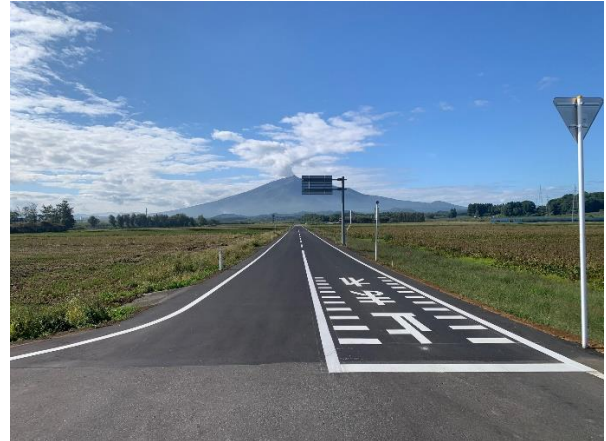
通作条件整備事業 舗装工
