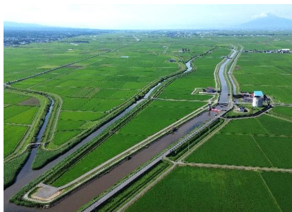
大区画ほ場整備を進めている 十三湖 2 期地区
