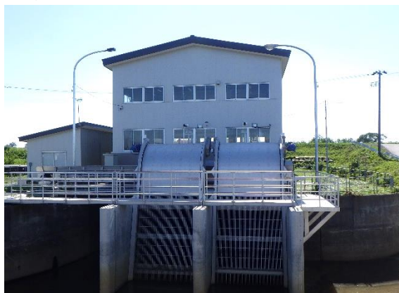
農業水利施設保全合理化事業 小田川南部地区 金木排水機場
