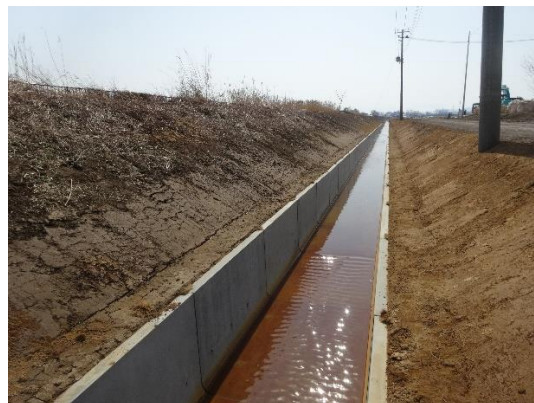
農業水路等長寿命化・防災減災事業 (水元排水路地区 つがる市 R3～R6)
