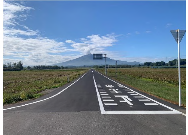
通作条件整備事業 舗装工
