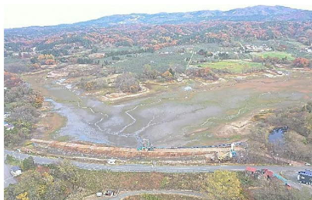
ため池等整備事業 (長橋地区 五所川原市 R 4～R 9)
