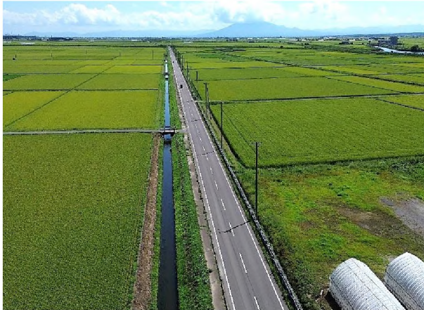
通作条件整備事業 舗装工
