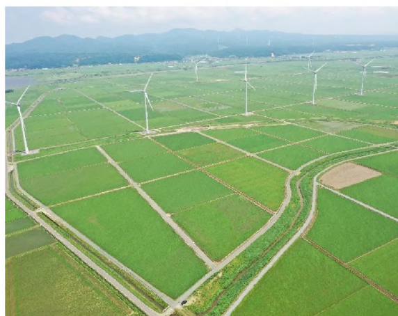
大区画ほ場整備を進めている 十三湖 2 期、十三湖 3 期地区
