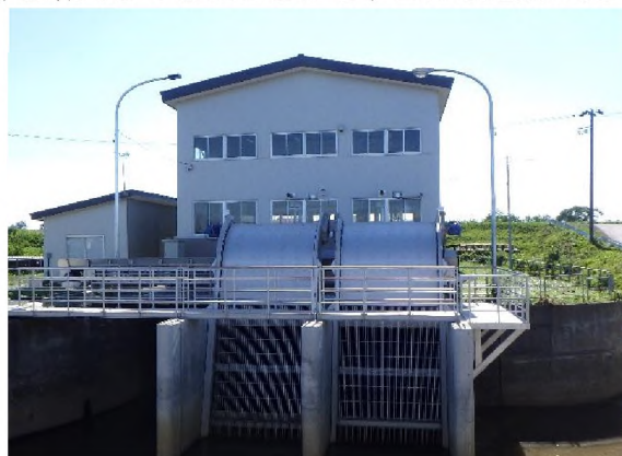
農業水利施設保全合理化事業 小田川南部地区 金木排水機場（H27～R 8）
