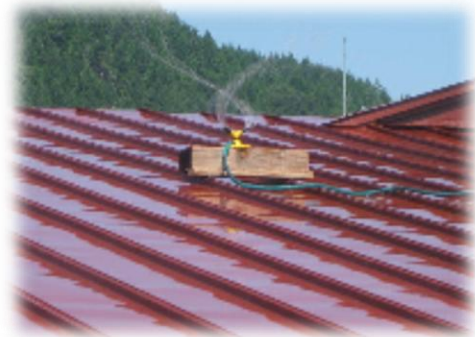
屋根への散水
