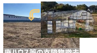
【荒廃農地の支障物撤去】
