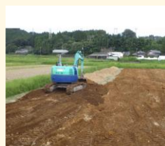
土層改良（客土）
