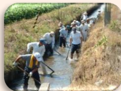
水路の泥上げ
