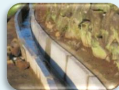
コンクリート水路の更新
