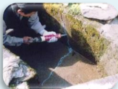
水路のひび割れ補修
