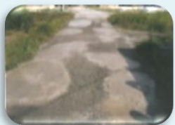
農道の窪みの補修
