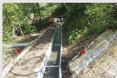
【農業用排水路】
