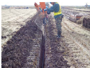
【暗渠排水の整備】
