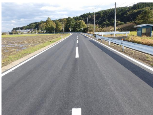
施工後の路面状況
