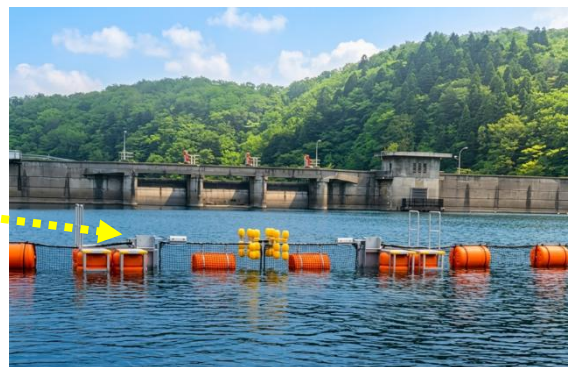
網場の設置状況（近接）
