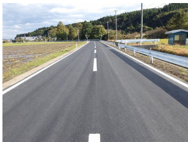
施工後の路面状況
