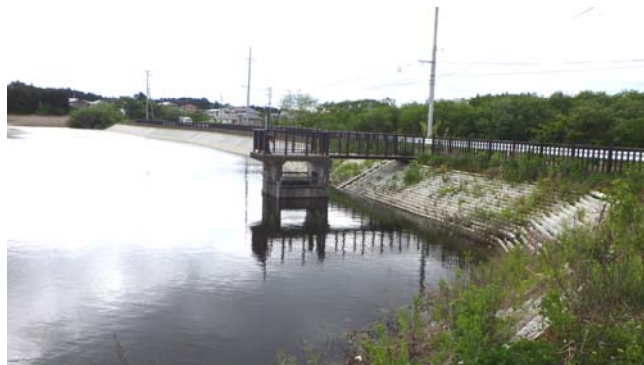
改修後の上谷地中堤地区
