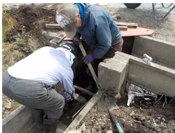
水路の目地補修（六戸町）
