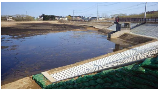
改修中の上谷地中堤地区
