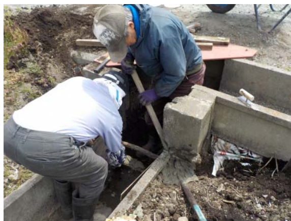
水路の目地補修（六戸町）
