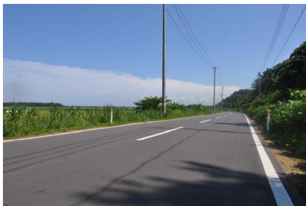
施工後の路面状況
