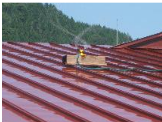
屋根への散水
