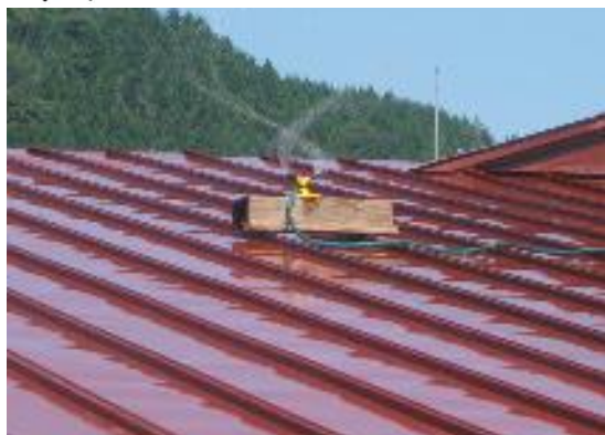
屋根への散水
