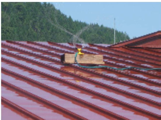
屋根への散水
