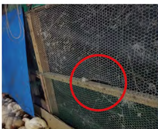
鶏舎側面の網の破損
