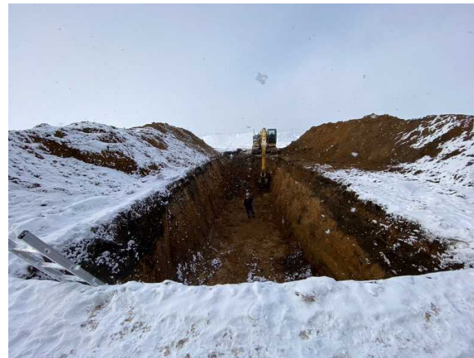
⑥2022. 12. 16 (10 時頃) 掘削作業の様子 2
