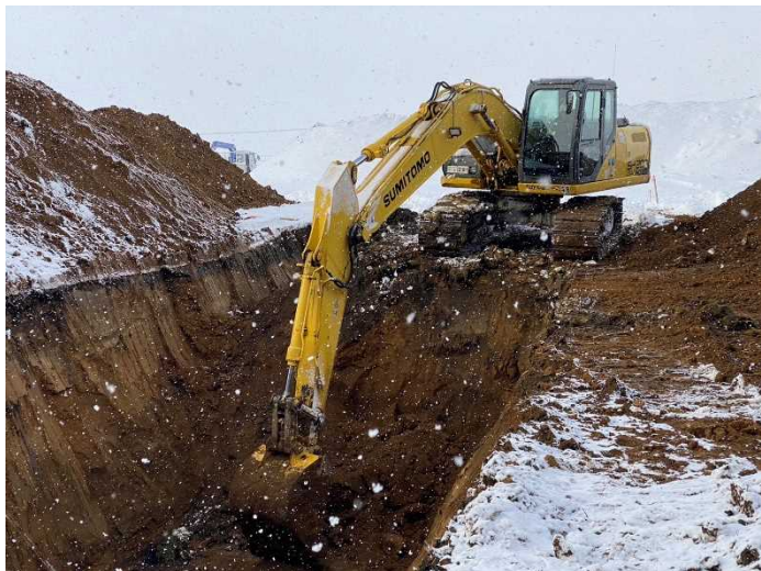
⑤2022. 12. 16 (10 時頃) 掘削作業の様子 1
