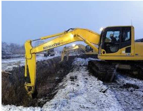
掘削などで使われる油圧ショベル
