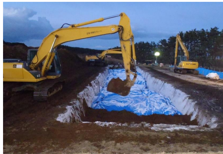
④2022. 12. 25 (16-17 時) 埋却作業の様子
