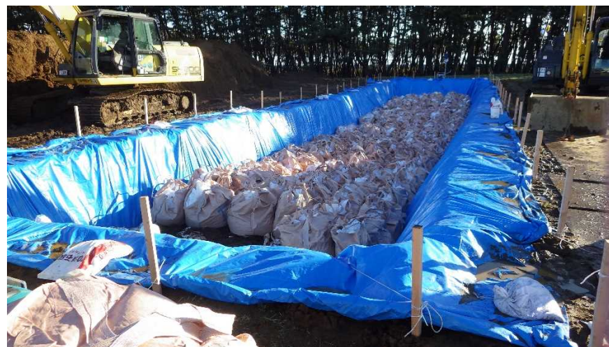
④2022. 12. 22 (12 時頃) フレコンバックの投入作業
