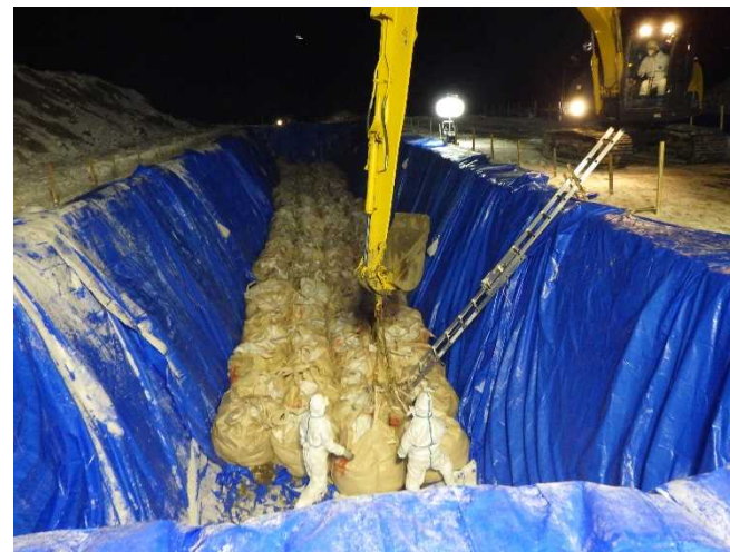
⑥2022. 12. 16 (18-19 時) フレコンバッグの投入作業 2
