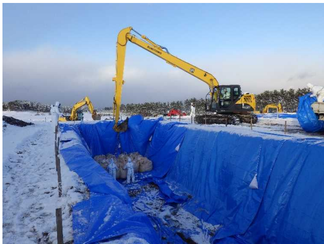
⑤2022. 12. 16 (15-16 時) フレコンバッグの投入作業 1
