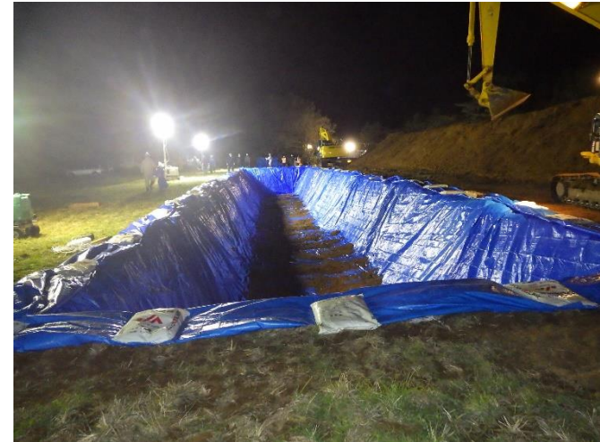
⑦2022. 11. 21 (2 時頃) ブルーシート設置
