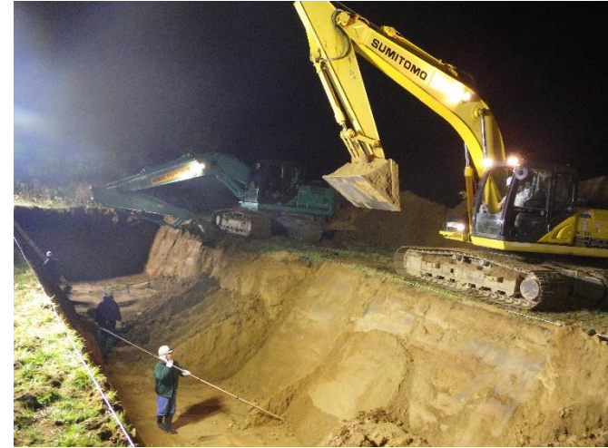
⑤2022. 11. 20 (21 時頃) 掘削作業中
