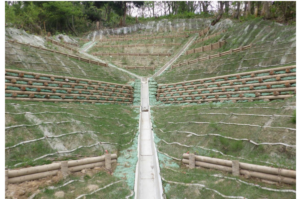
間伐材を活用した山腹工の施工状況
