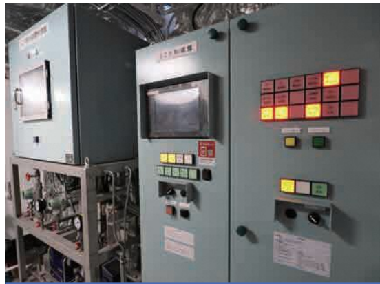
脱硝装置 (SCR)
