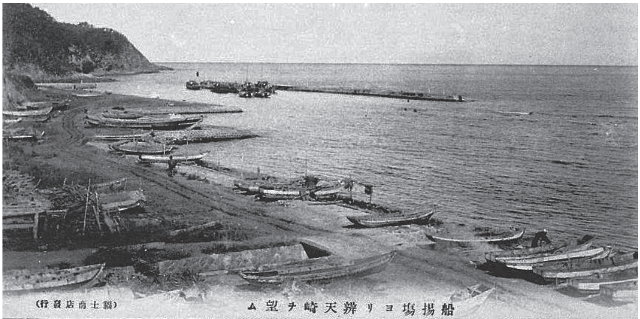
写真5 船揚場より弁天崎を望む（小泊）
