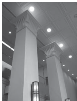
写真 20 柱 (みち銀国道支店)
