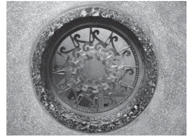
写真5 階段透かし窓
