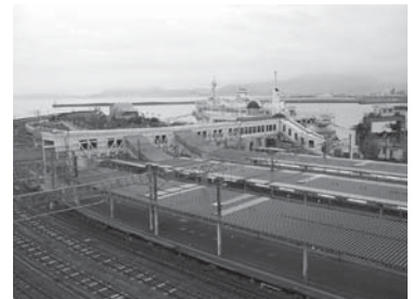
写真 56 ホームと連絡船との連絡通路
