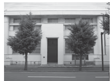
写真 2 郷土館旧館の外観
