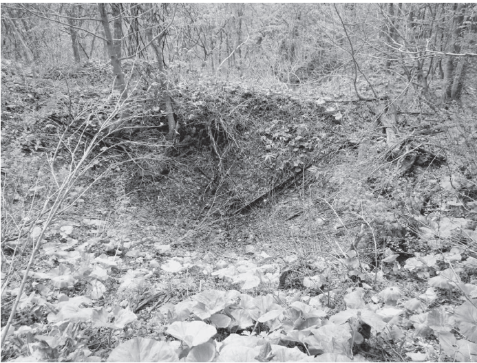
写真10 坑道奥の石灰石流入口の真上と思われる窪地
