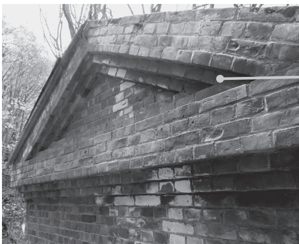
写真17 レンガの積み方（全体的にはイギリス積み）
