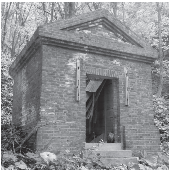
写真15 斜め前方から見た火薬庫
