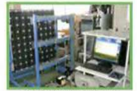
太陽光発電実験装置
