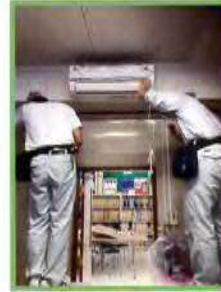
エアコン取付実習
