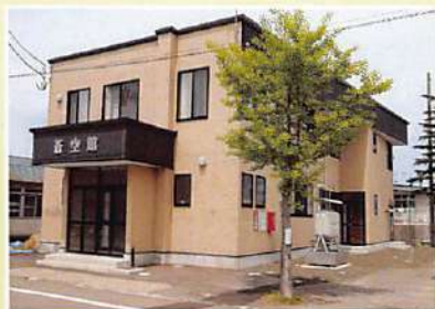
生徒会館「蒼空館」
